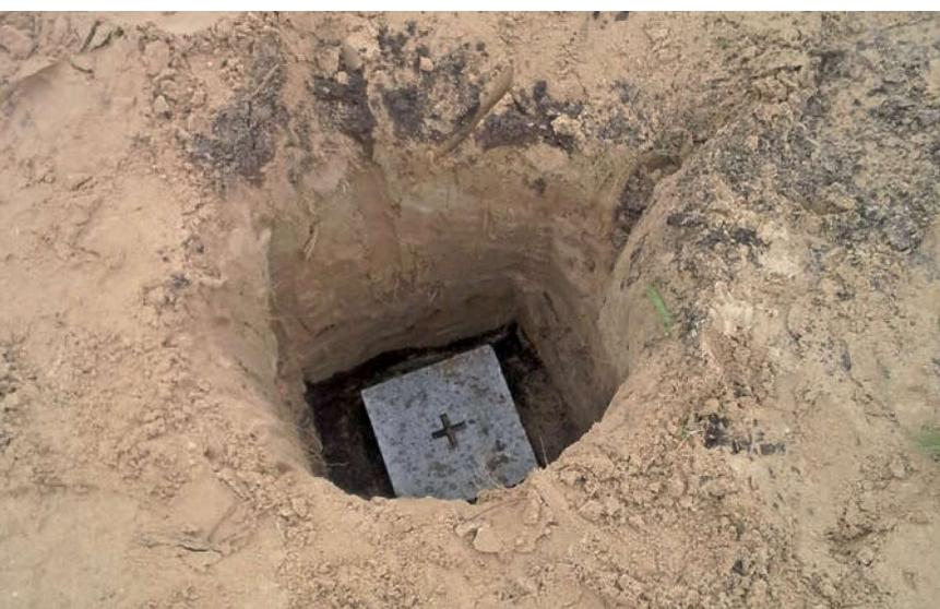
Abb. 2: Neue unterirdische Sicherung eines Grenzsteines
